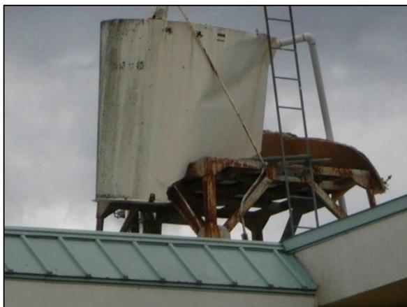
貯水槽 断裂損壊
