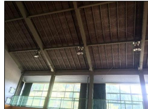
天井ブレース(筋交い)破損 13カ所
