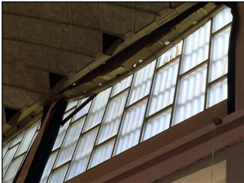
カーテン設置部天井板の破損(右側)
