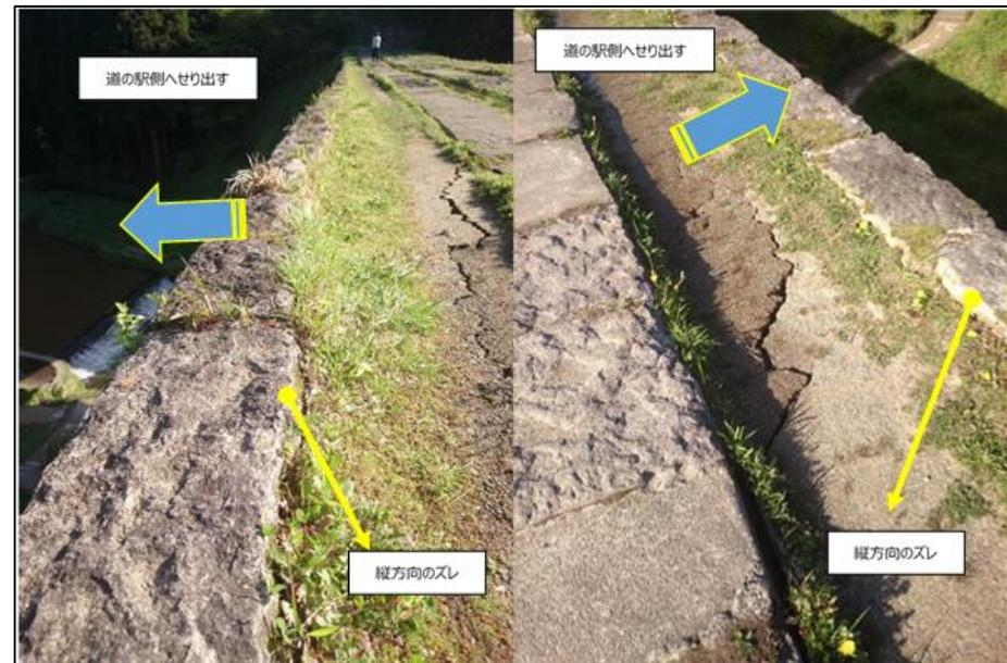
被覆土で確認された亀裂と手摺石のズレ
