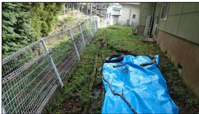
金内保育園 園舎裏の亀裂
