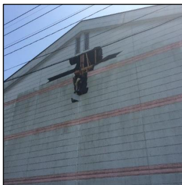
外壁の破損
