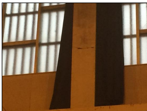
3階鉄筋支柱にクラック(8本中 6本にクラック発生)
