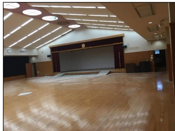
千寿苑多目的ホール 照明板落下
