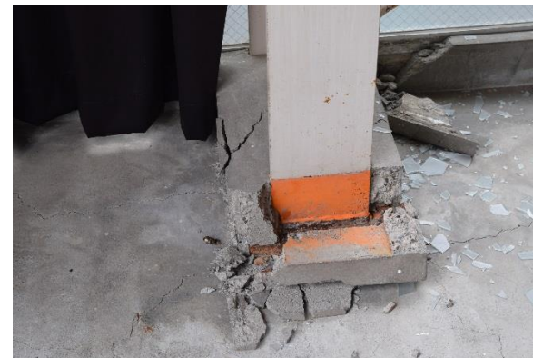
体育館 2階鉄骨接続部付近損壊(使用禁止)
