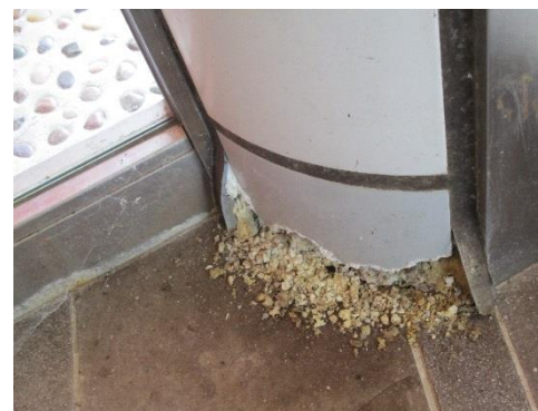
B館1階柱損傷
