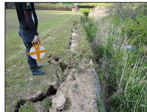
大野川(護岸亀裂)
