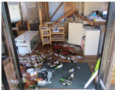
レストラン等損傷
