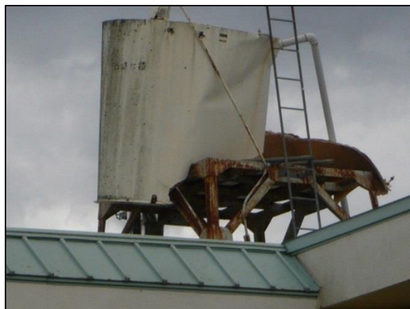
貯水槽 断裂損壊
