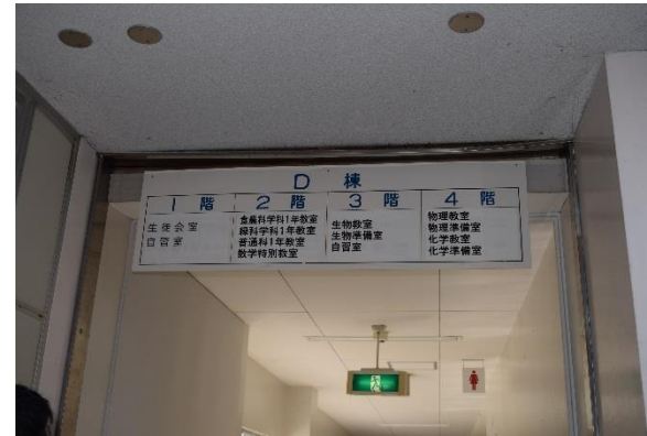
D棟-E棟接続部損傷(通行禁止)
