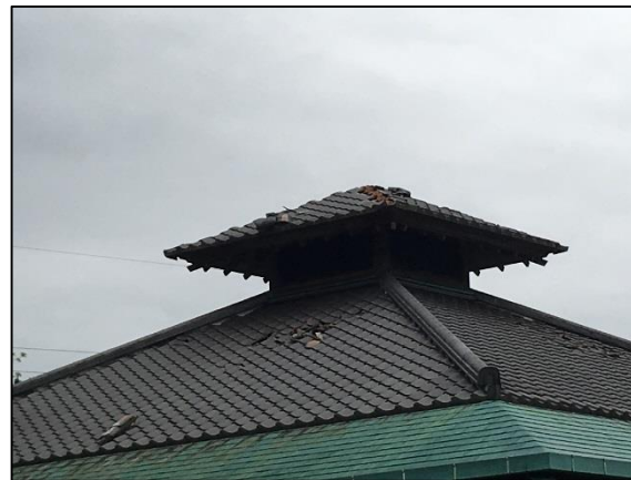
千寿苑屋根瓦破損
