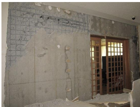
温泉館壁面破損
