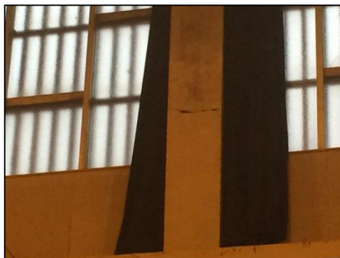
3階鉄筋支柱にクラック(8本中 6本にクラック発生)
