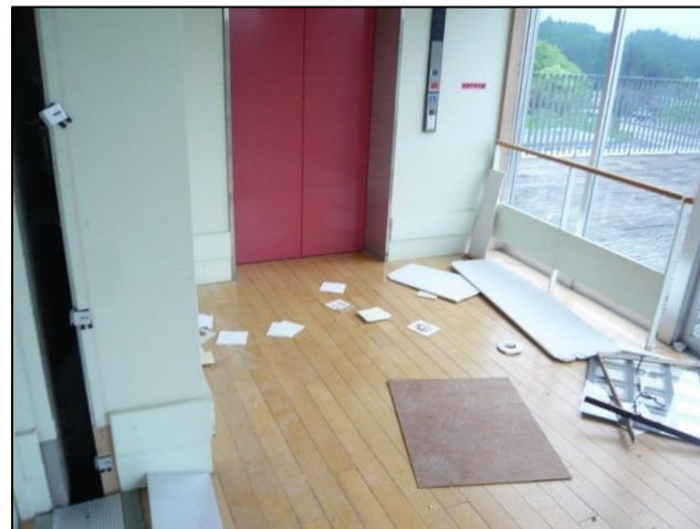
エレベーター及びエレベーターホール損壊
