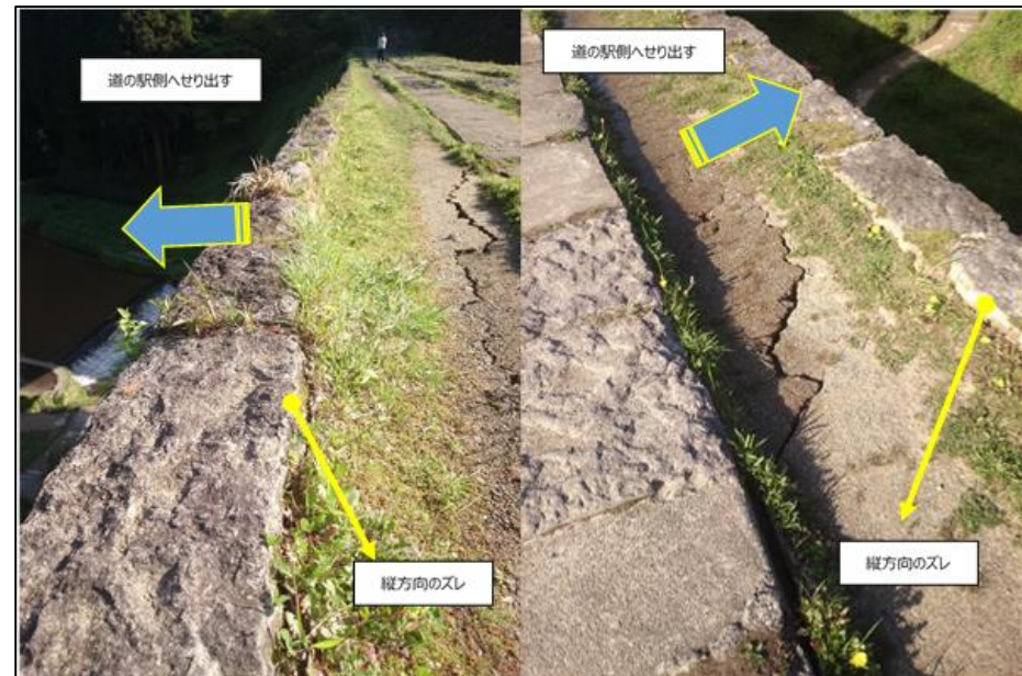
被覆土で確認された亀裂と手摺石のズレ (左:右岸上流側、右:左岸上流側)
