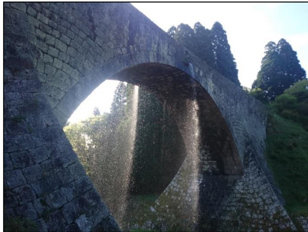
アーチ下部より全面的に漏水
