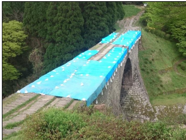
雨水流入防止を目的とした応急処置
