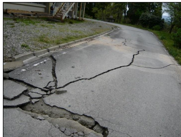
敷地内道路 地面亀裂
