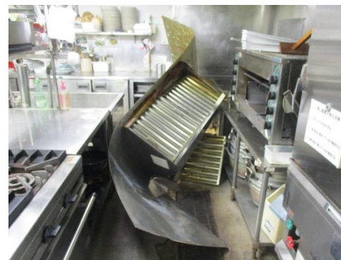
レストラン ダクトカバー落下
