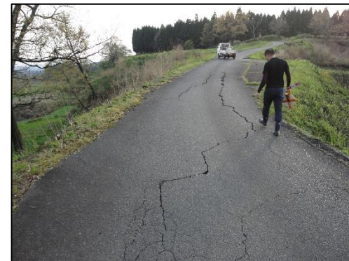
上寺・造別当線(路面亀裂)
