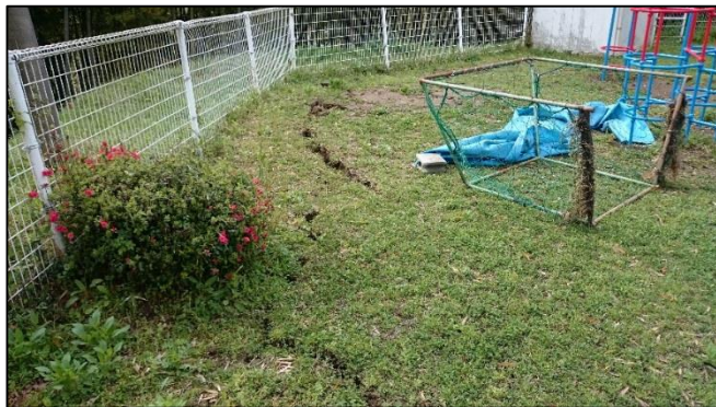
金内保育園 園庭の亀裂
