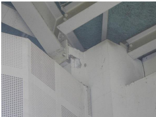
体育館 屋根鉄骨接続部付近クラック
