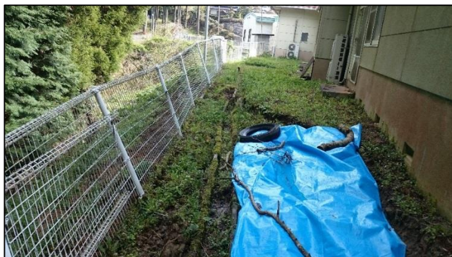
金内保育園 園舎裏の亀裂
