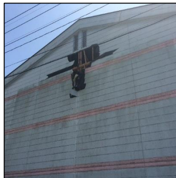
外壁の破損
