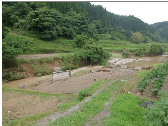
牧野 谷山地区 河川流出 ※河川右側は全て田
