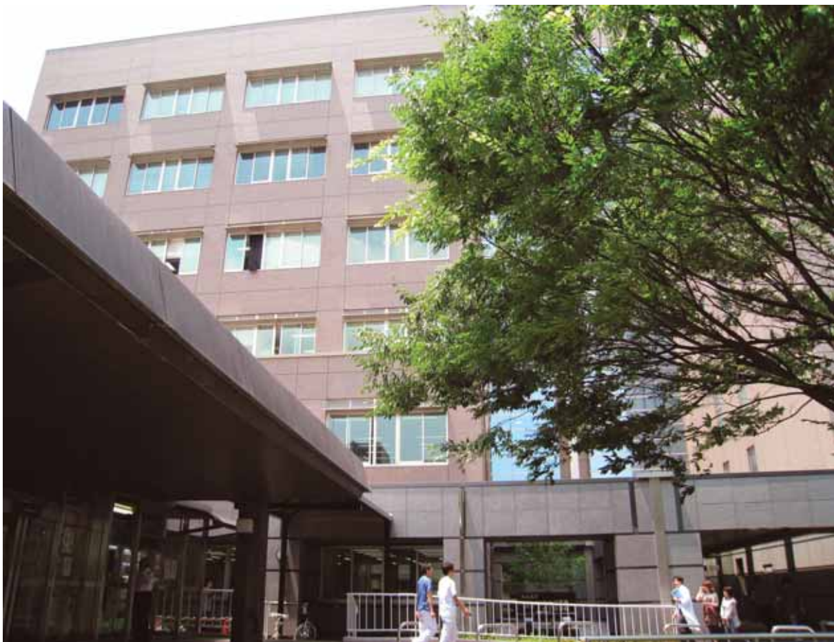
平成21年4月より医学系分館が移転した医学教育図書棟
