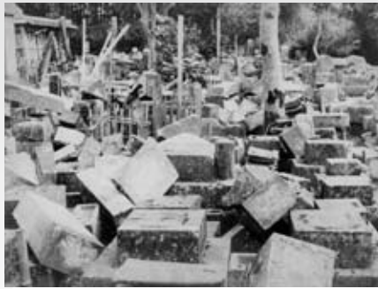
倒壊した墓石(熊本市坪井の見性寺)
