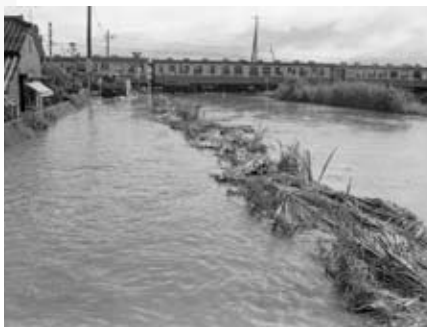
昭和47年水害 氾濫した網津川（住吉踏切付近）
