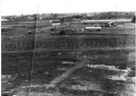
新市庁舎の建設地（浦田町）
