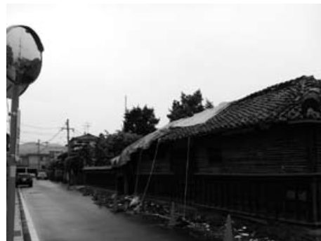
← 門内町武家屋敷「旧高月邸」被災状況 瓦の落下、建物の傾きなど大きな被害あり。平成29年度に補強も含めた復旧工事を予定。
