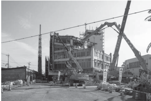
市役所の解体工事
