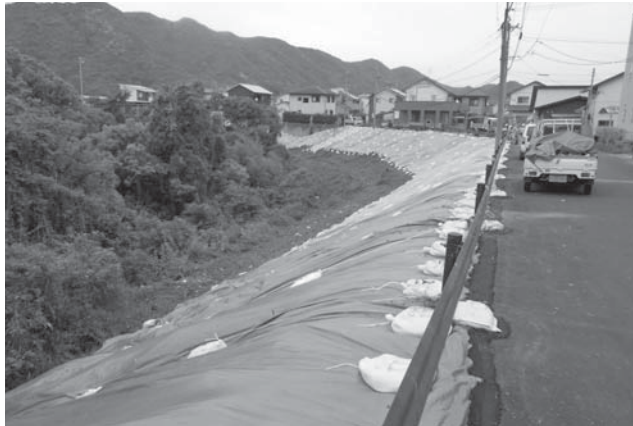
宅地造成地（花園台）の被害状況
