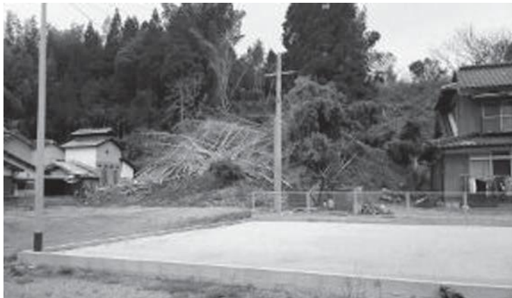
地震により亀裂が走り大雨によって崩壊した椿原町の屋
