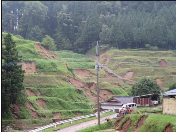
白小野 名ヶ地区 棚田斜面崩落
